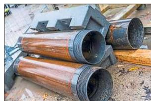
219 Millimeter dicke Rohre für den Weg bis zum Mergel.
