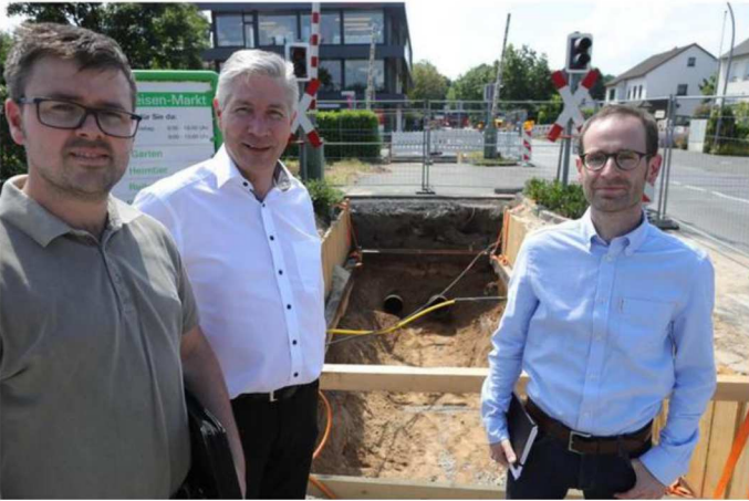
Frank Höwelhasse, Heribert Schönauer und Florian Ostermann vor der Baugrube an den Bahnschranken, wo zurzeit noch die verlegten Rohre enden. Von hier werden die Leitungen noch bis zur Paderborner Straße fortgeführt. Foto: Matthias Kleemann
