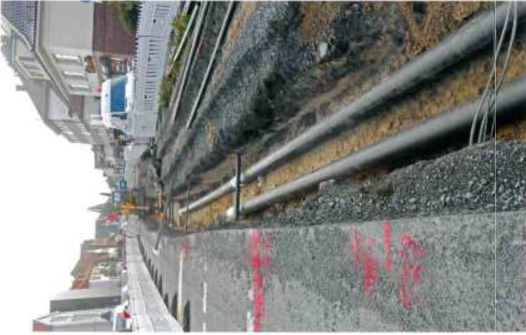
Per Biogasleitung wird dieses Satelliten-BHKw einer Biogasanlage im Umland mit Brennstoff versorgt, das seine Wärme vollständig in das Fernwärmenetz der Stadt einspeist.
