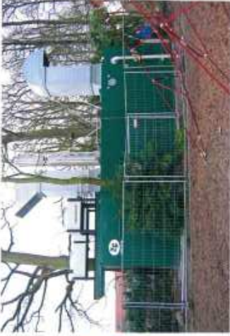
Per Biogasleitung wird dieses Satelliten-BHKw einer Biogasanlage im Umland mit Brennstoff versorgt, das seine Wärme vollständig in das Fernwärmenetz der Stadt einspeist.
