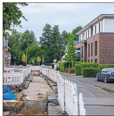
Das erste Teilstück ist verlegt: Blick von der Paderborner Straße in die Poststraße.
