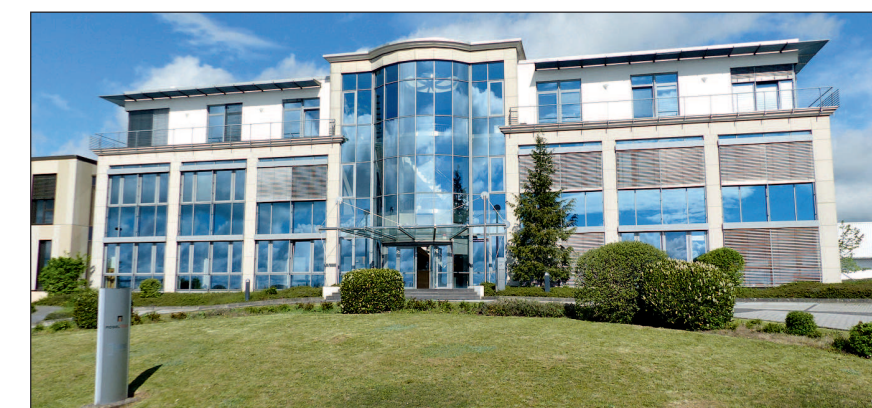
Verwaltungszentrale von Borne in Trierweiler: In den deutschen Standort werden aktuell etwa 45 Mio. Euro investiert. Dazu gehört auch eine neue Energieversorgung auf Basis eigener Produktionsreste.
