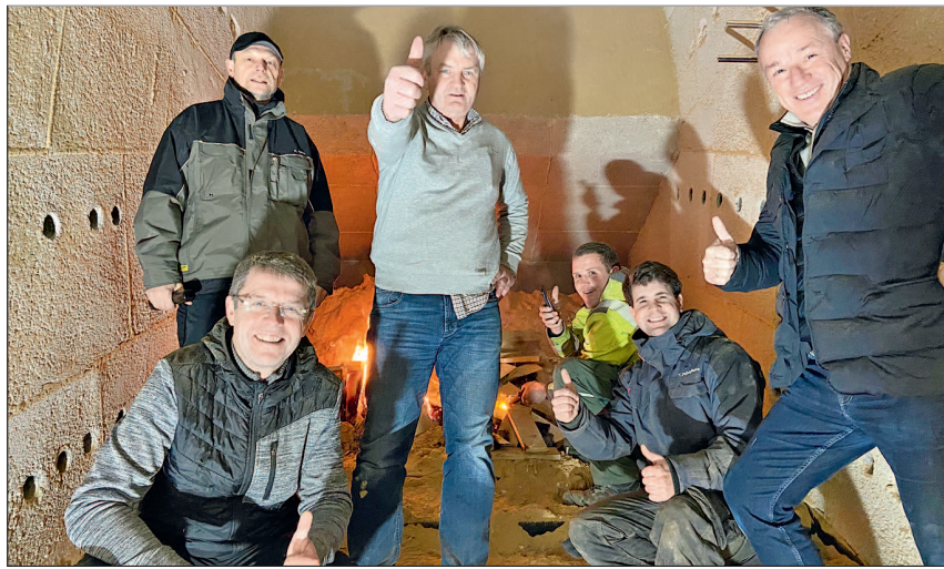
Im Frühjahr wurde in der Feuerung erstmals eingehiezt (von links): Norbert Linenberger, EAL; Frantisek Cech, Vyncke; Heinz-Josef Rodehuth, Senne Energie; Cedric Trienens, Senne Energie; Thomas Dejaeghere, Vyncke, und Frank Borne
