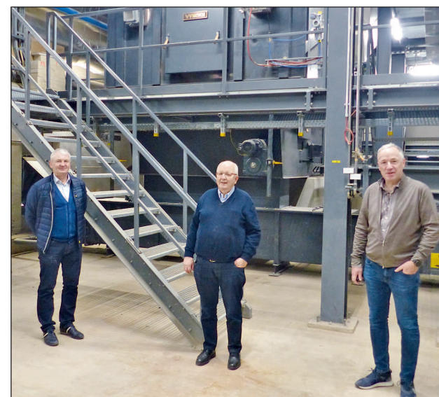
Im Frühjahr lief die Anlage im Regelbetrieb, es folgten der Endausbau mit Nachverstromungsanlagen und Optimierungen. Vor der Feuerung (von rechts): Frank Borne, Dr. Dieter Brechmann und Heinz-Josef Rodehuth
