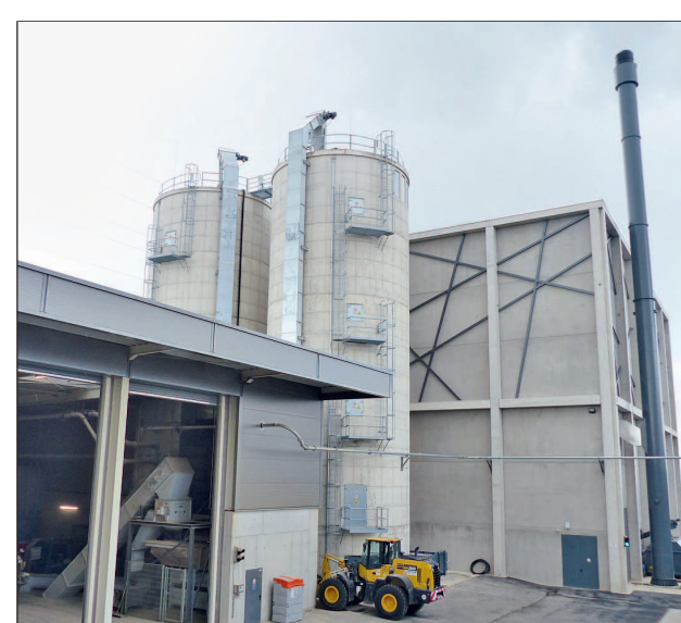
Das fertige Kesselhaus mit Holzaufbereitung (links), Spänesilos und automatischer Eingangswaage (rechts, unten)
