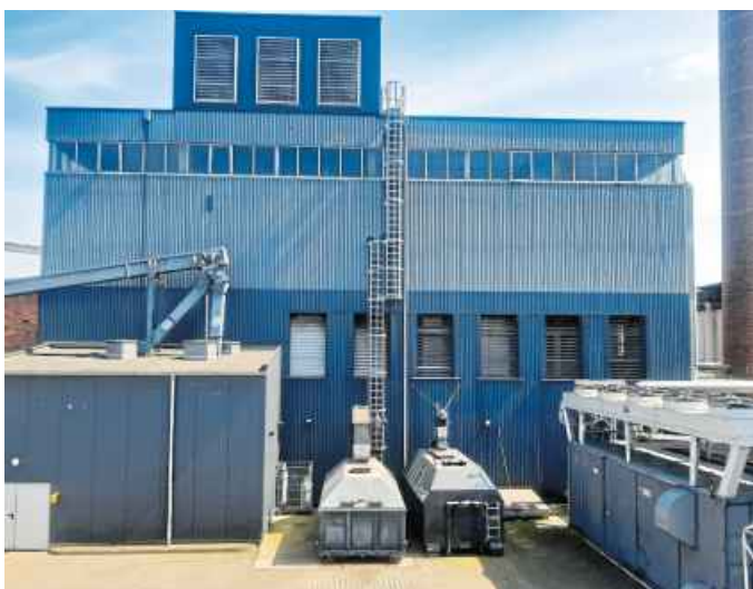
Das Hövelhofer Holzheizkraftwerk wurde 2007 für rund 6,8 Millionen Euro errichtet. Foto: Rodehuth Holzenergie
